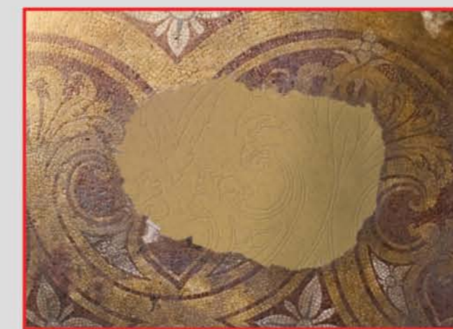
Integrazione con malta dello stesso colore degli ornati
