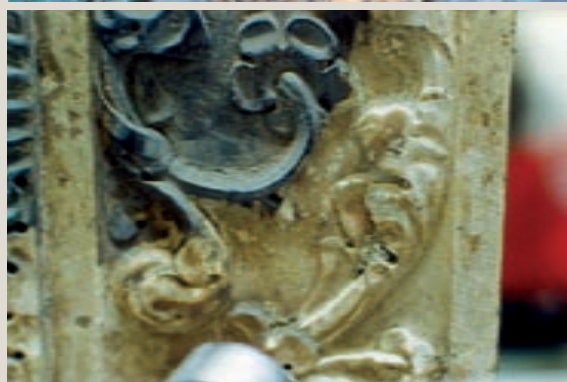
Particolare del momento di pulitura, si vede la luminosità del punto trattato.
