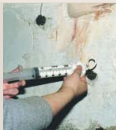
4. Iniezione di caseinato di calcio mediante siringa e cannula flessibile in Pvc per preconsolidare le discontinuità presenti nell'intonaco dipinto.
