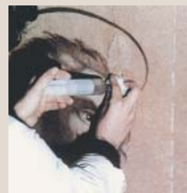
1. Iniezione di maltina adesiva con siringa tra intonaco e supporto.
