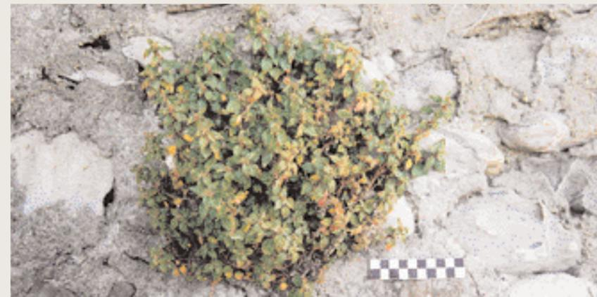
1. Esempio di pianta superiore (parietaria) insediata nelle discontinuità di una muratura in pietra in parte intonacata.
