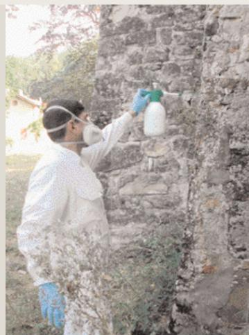
**3. Applicazione del prodotto biocida (Ipoclorito di sodio) con spruzzatore manuale.**
