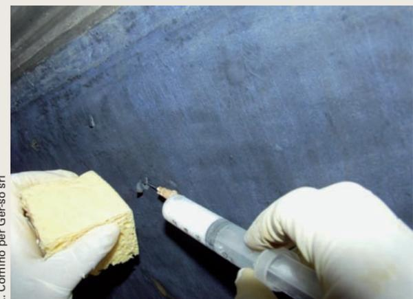
**Riadesione del frammento sollevato mediante una leggera pressione con una spugna morbida e pulita.**
