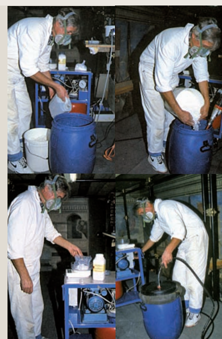
Preparazione sottovuoto dell'impacco di idrossido di bario: acqua deionizzata, pasta cellulosica, idrossido di bario. Messa in azione della pompa per creare il sottovuoto.
