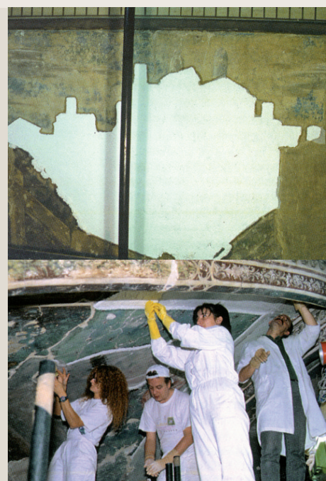
Consolidamento finale con stesura dell'impacco di idrossido di bario.
