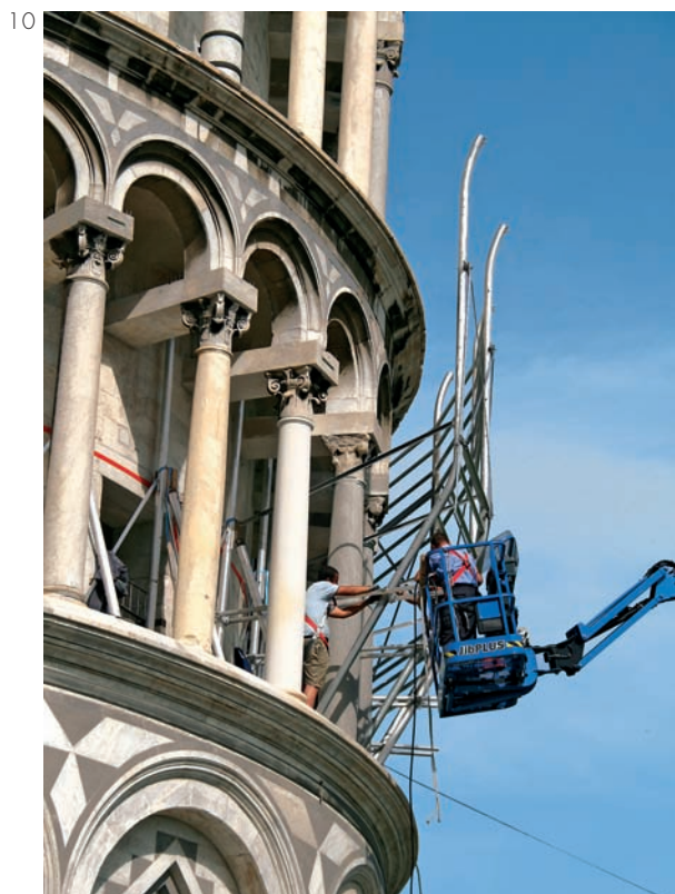
FIGURA 10 • Una fase del montaggio dello speciale ponteggio realizzato per il restauro delle superfici della torre di Pisa, nel maggio 2008.
