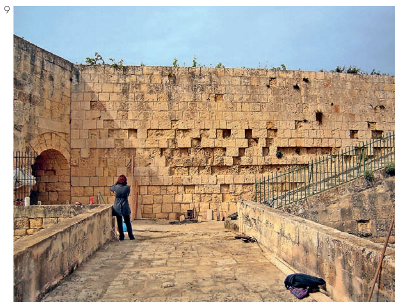
FIGURA 9 • La Valletta, Malta, porzione di mura integrata con sostituzione dei conci erosi.
