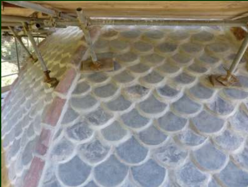
Il Cantiere: esiti dell'intervento in copertura
