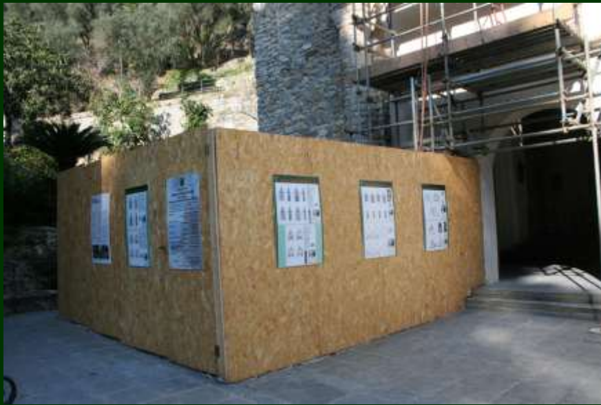
Il Cantiere: il box alla base del ponteggio
