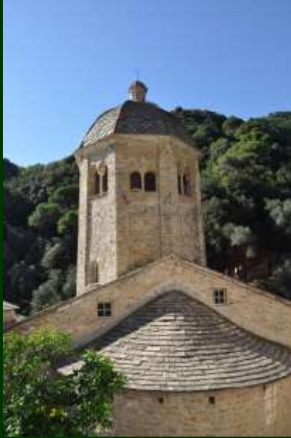
Il Cantiere: prima e dopo i lavori
