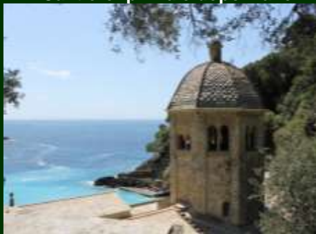
Il Cantiere: prima e dopo i lavori
