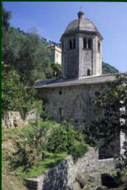
Il Cantiere: prima e dopo i lavori
