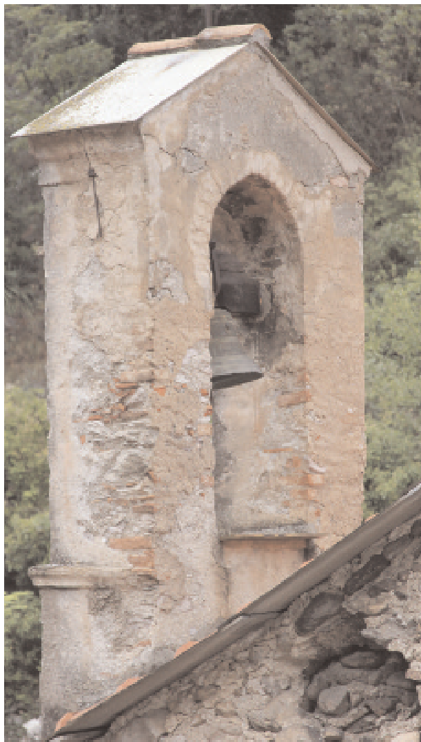
Campanile a vela che si imposta sulla parete Nord dell'atrio di ingresso all'Oratorio.
