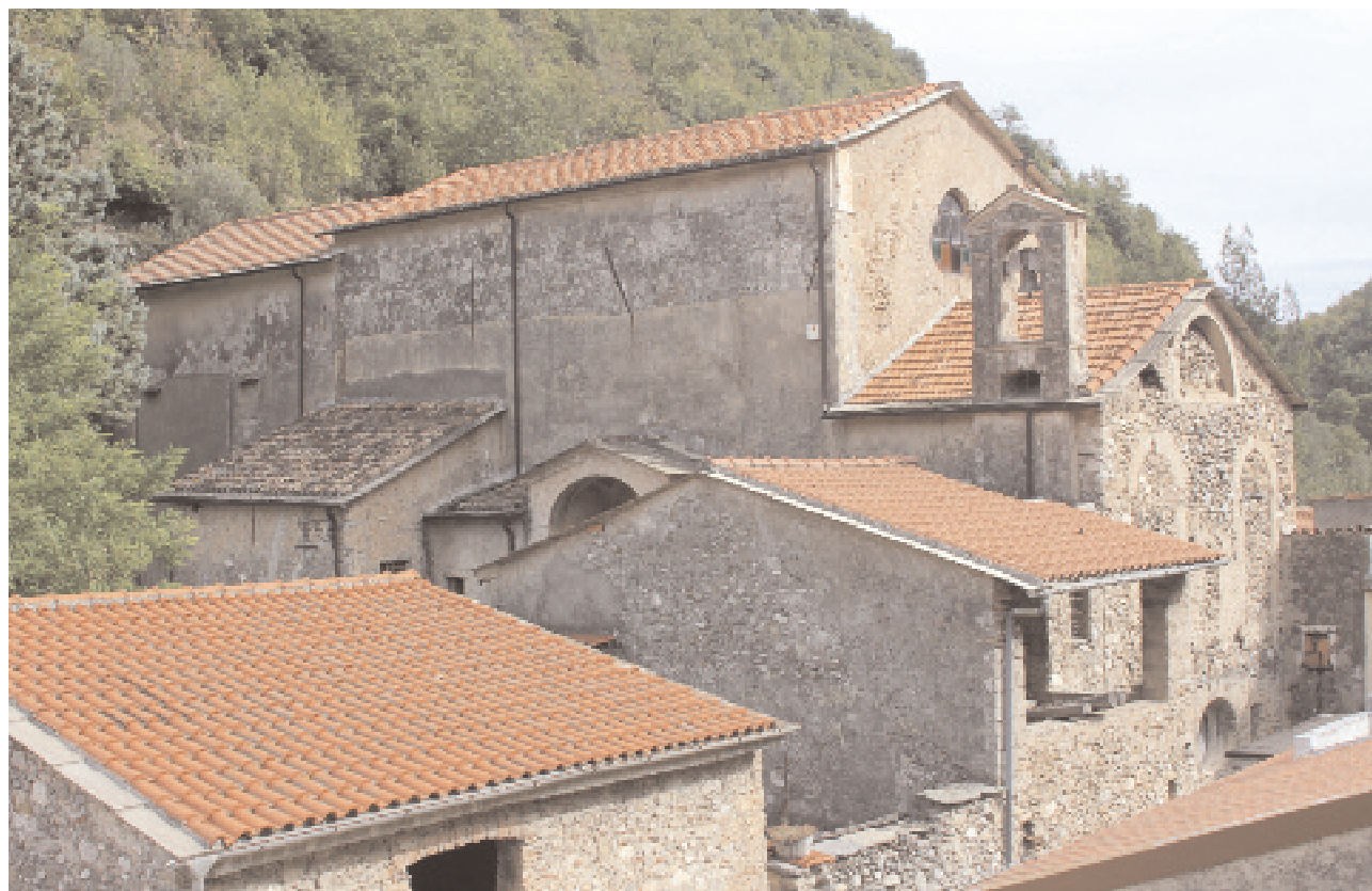
L'edificio visto da Nord-Ovest.
