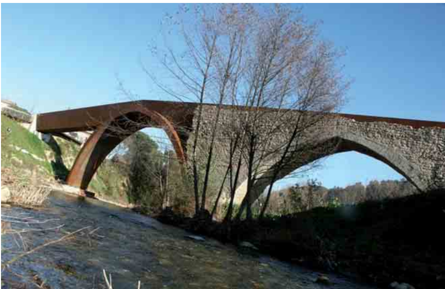
Fig. 2 Tordera, Spain, Pont Trençat after the integra- tion (2000-2004)
