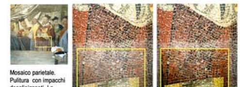
Mosaico parietale. Pulitura con impacchi desalinizzanti. La superficie non ancora pulita si presenta opaca e biancastra per la presenza dei sali. Particolare di una porzione di mosaico non ancora pulita. Pulitura elaborata utilizzando come riferimento la pulitura reale.
