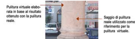
Pulitura virtuale elaborata in base al risultato ottenuto con la pulitura reale. Saggio di pulitura reale utilizzato come riferimento per la pulitura virtuale.
