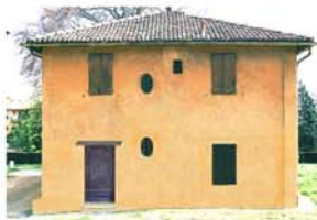
Simulazione della velatura dei rappezzi e delle zone dove la tinta originale risulta abrasa o scomparsa. La simulazione mostra come una soluzione di questo genere, oltre ad essere più rispettosa del manufatto originale, consente di ottenere comunque un risultato "decoroso" di riuniformazione cromatica.
