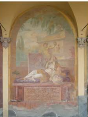
Chiostro III, Certosa di Bologna. Dipinto murale con una estesa lacuna nella parte basamentale dovuta all'umidità di risalita.
