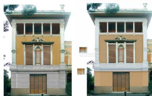
Villa Quartara Spina - Genova. Simulazione di varie proposte di intervento di ricoloritura delle superfici esterne. L'ultima simulazione è quella scelta per l'intervento; sulla sinistra dell'immagine sono visibili i campioni reali utilizzati per la simulazione degli interventi.
