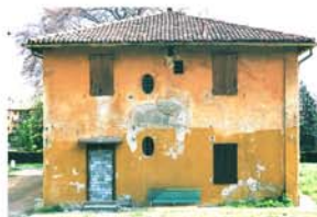
Villa delle Rose, Bologna, Casina del Custode. Facciata dell'edificio prima della simulazione degli interventi.
