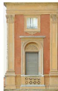
Simulazione della integrazione delle lacune e del rafforzamento a velatura dell'ultimo ciclo di coloritura (rosso per i fondi e giallo ocra per le membrature architettoniche).
