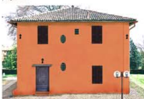
Simulazione dell'intervento di sostituzione totale degli intonaci e della pitturazione coprente del nuovo strato con due tinte diverse. La simulazione dimostra che la pitturazione coprente determina un "effetto cartone" molto lontano dalle caratteristiche trasparenza delle tinte a calce originali. E' stata anche simulata l'installazione di corpi illuminanti sulla facciata e nei pressi dell'edificio.
