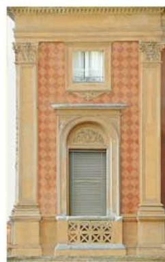
Simulazione della integrazione della decorazione originale geometrica a rombi gialli e rossi, elaborata mediante il rafforzamento a velatura della decorazione originale ancora leggibile sulle superfici.
