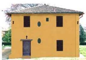
Simulazione dell'intervento di sostituzione totale degli intonaci e della pitturazione coprente del nuovo strato con due tinte diverse. La simulazione dimostra che la pitturazione coprente determina un "effetto cartone" molto lontano dalle caratteristiche trasparenza delle tinte a calce originali. E' stata anche simulata l'installazione di corpi illuminanti sulla facciata e nei pressi dell'edificio.
